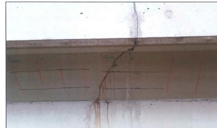
Obr. 5 Schématický náčrt výztuže na konstrukci – 2. pole, levá strana mostu
